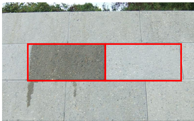
写真-7 湿潤状態（左側）と乾燥状態（右側）における色差
