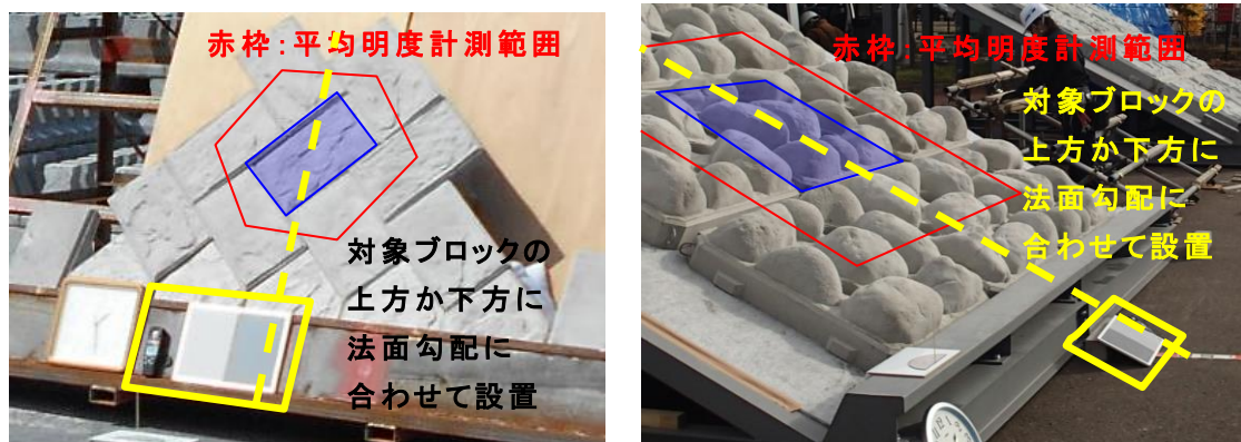
写真-13 照度計と補正板の設置状況
