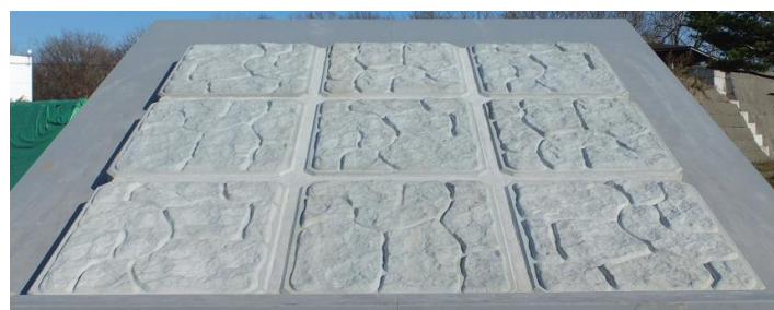
連結部等の間詰充填を行う
