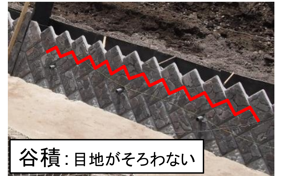
図1 間知ブロックを谷積にした形式
