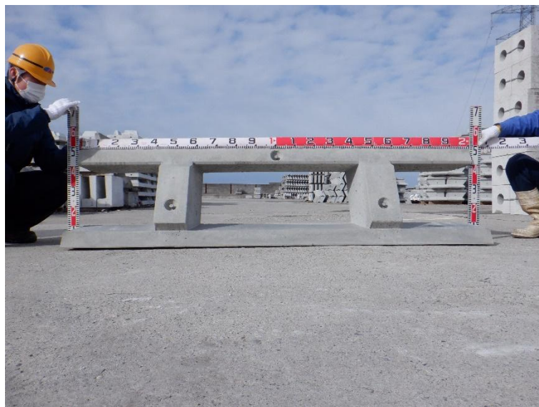
写真-9 積みブロックの上面の撮影例（背面板型：横幅2.0m×控長0.5mの場合）
