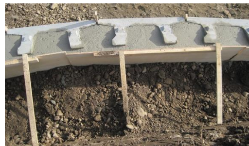
積みブロックどうしの接合部と 打継ぎ面がそろっている例
